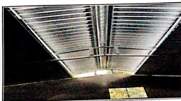
FOTO 5: INSTALACION DE ESTRUCTURAS Y ENTECHADO CON LAMINAS TROQUELADAS.
