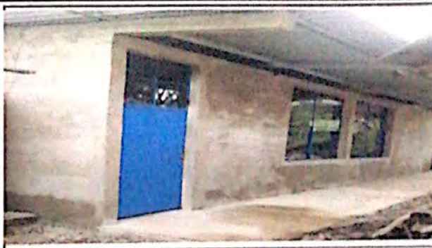
FOTO 2: SUSTITUCION DE 2 PUERTAS DE METALICAS
