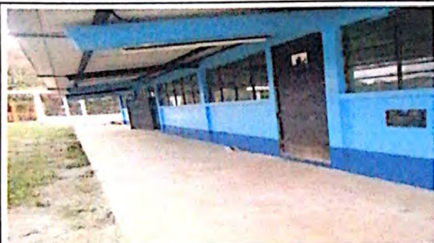
FOTO 1: PINTURAS DE DOS AULAS
