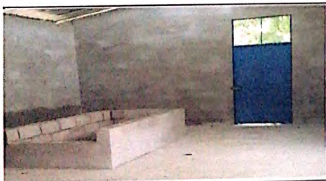
FOTO 3: SUSTTITUCION DE PISO Y POLLETON DE LA COCINA.
