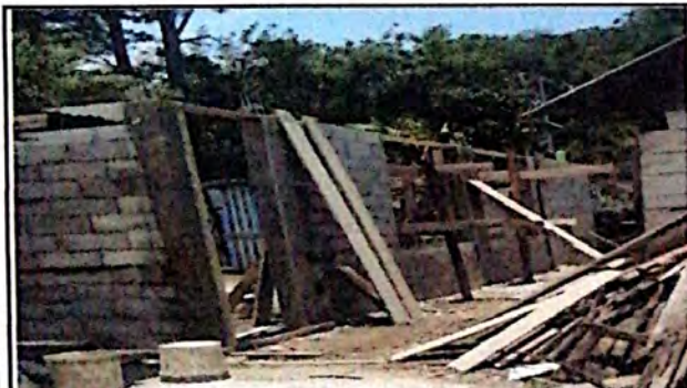
FOTO 3: SUSTITUCION DE COLUMNAS DE CONCRETOS.
