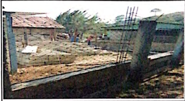
FOTO 2: SUSTITUCION DE SOLERA DE INTERMEDIA.
