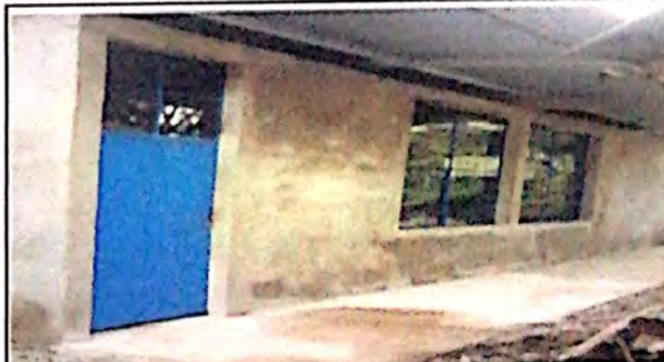
FOTO 4: INSTALACION DE VENTANAS METALICAS Y VIDRIOS.
