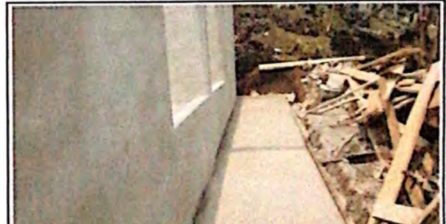
FOTO 6: SUSTITUCION RAMPAS Y VENTANAS.
